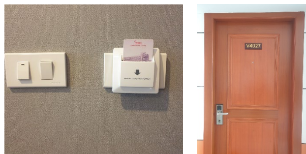
รูปที่ 3.2-22 ระบบ access control ด้วยระบบ keycard และระบบ control การใช้พลังงานภายในห้องพัก
